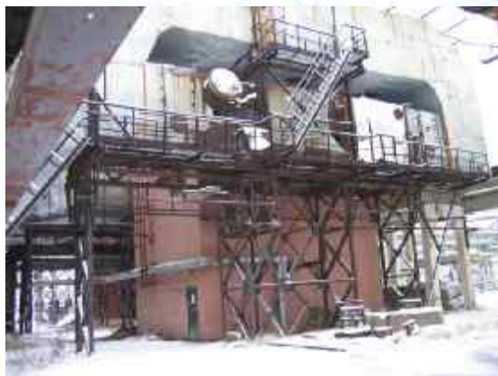
Установка на ТЭЦ-15
